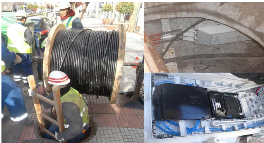
Ilustración 14. Tendido y empalme de cables en canalización.
