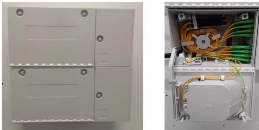
Ilustración 17-2. Caja terminal óptica (CTO) interior, con tamaño y nº de usuarios reducido.
